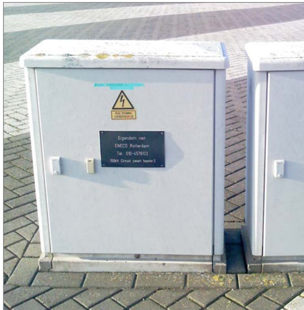
fig. 7 Voorbeeld van een cross-bondingkast
