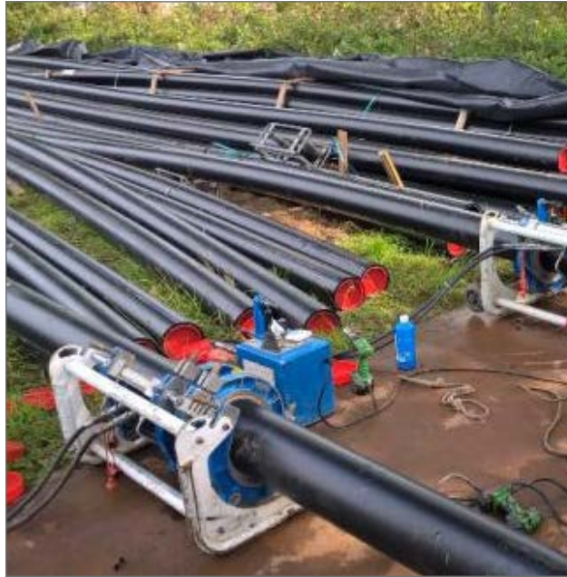
fig. 6 Mantelbuizen op uitleglocaties
